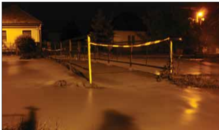
Dolný most úplne pod vodou (2. jún 2010)
