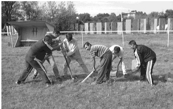
Zamestnanci obce v rámci verejnoprospešných prác pri odstraňovaní betónových obrubníkov v športovom areáli
